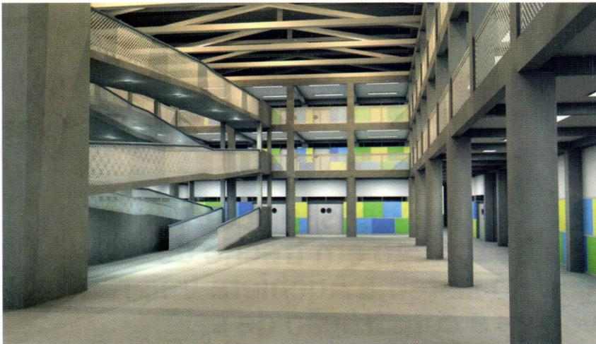
A estrutura do edifício será em peças pré-fabricadas de concreto armado e estará associada a perfis metálicos para sustentação da cobertura. Todas as escolas serão dotadas de escadarias internas e de rampas – ou elevadores – para garantir total acessibilidade aos diversos ambientes
