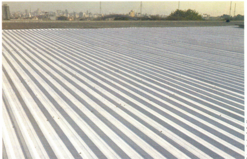
Figura 1 – A manutenção de coberturas metálicas deve prever a total remoção das áreas corroídas e nova pintura com tinta à base de zinco seguida de acabamento
