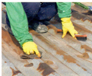
Figura 8 – Lixamento da área danificada
