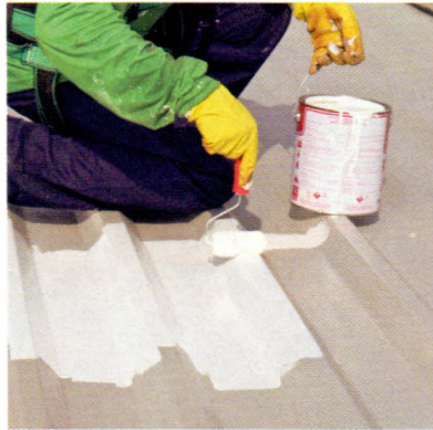
Figura 11 – Aplicação da pintura de acabamento
