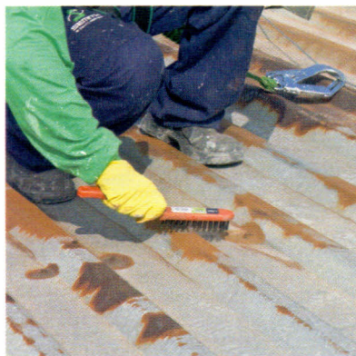
Figura 6 – Remoção de ferrugem com escova de aço
