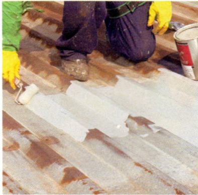
Figura 10 – Aplicação de demão de fundo à base de zinco
