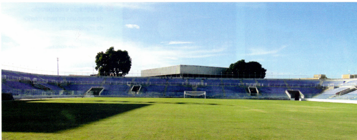
As obras iniciadas em janeiro de 2010 alteraram tanto a funcionalidade como o partido estrutural
