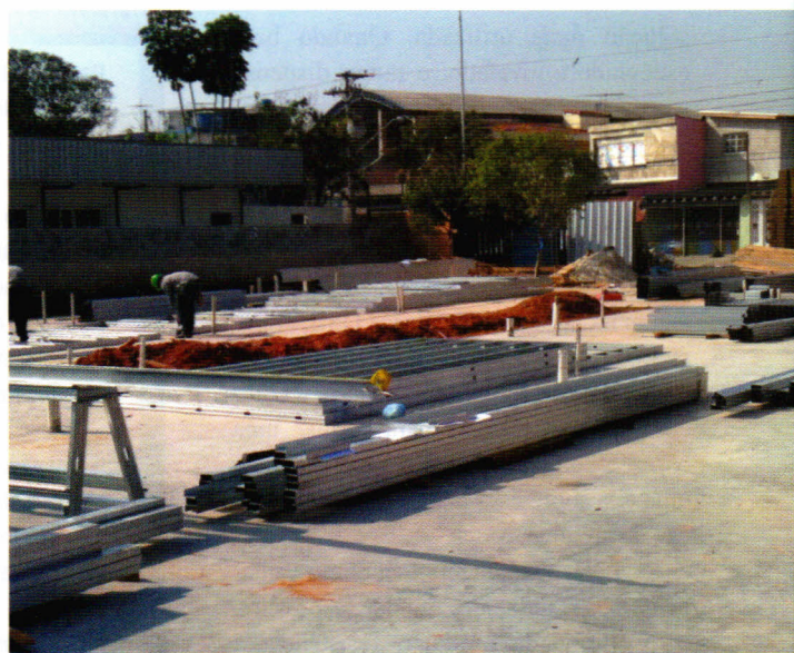
Perfis sobre fundação de radier e estrutura montada na UPA construída no bairro de Sacadura Cabral, em Santo André (SP)
