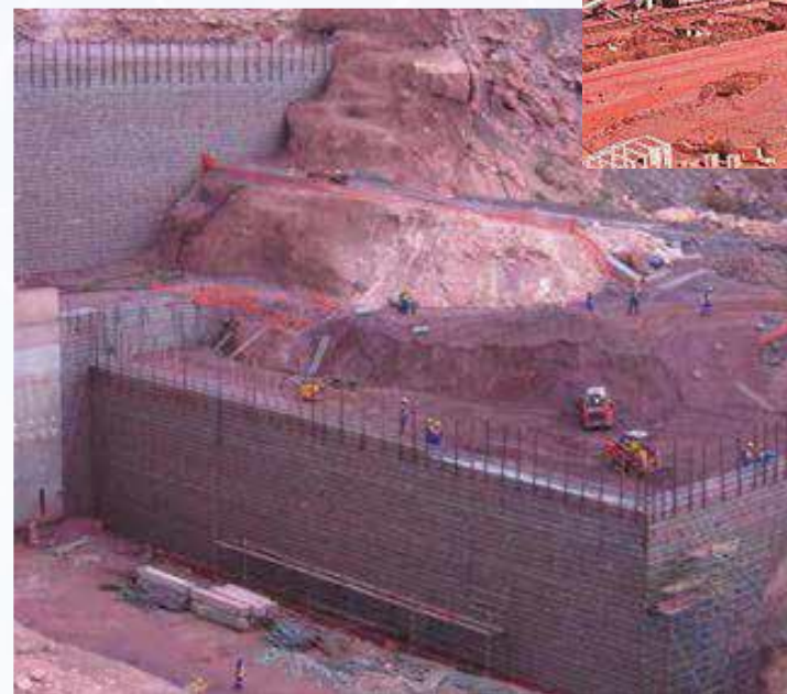
Parede B de britador quase completa
