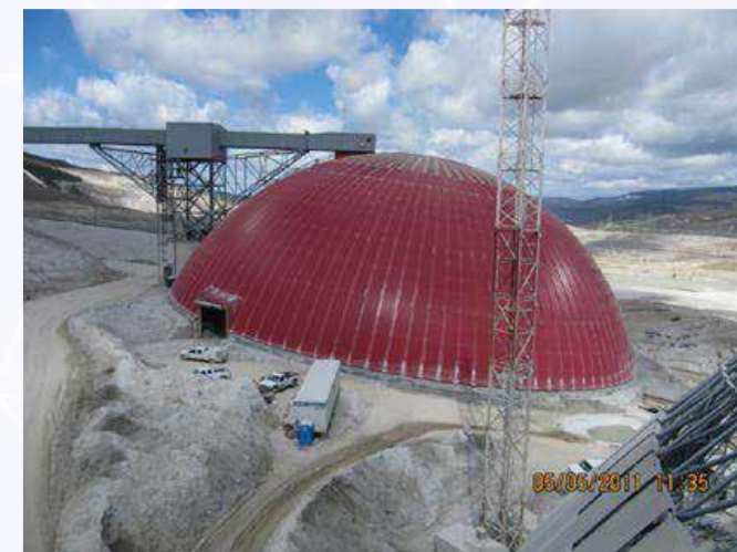
Abóbada para Armazenamento da Mina de Cobre Highland Valley
