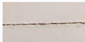
Pintura sobre aço galvanizado
