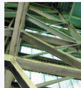
Estrutura de aço na Mina de Carvão Goedehoop
