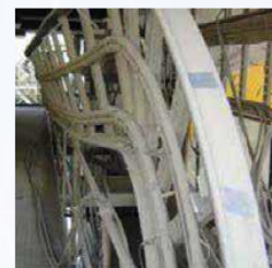
Escadas de cabo de aço in loco na Estação de Transferência N° 1, considerada supérflua
