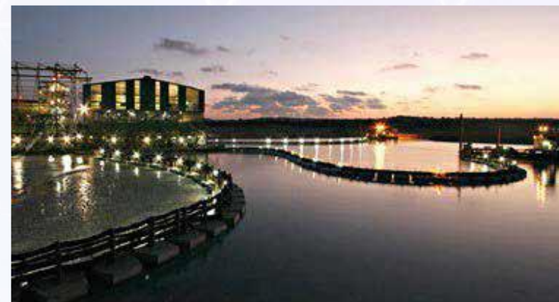
Instalações de concentrador de líquidos e drenos em operação à noite
