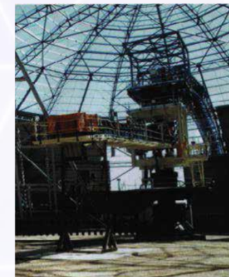
Abóbada para armazenamento de reservas na Mina Skorpion em construção
