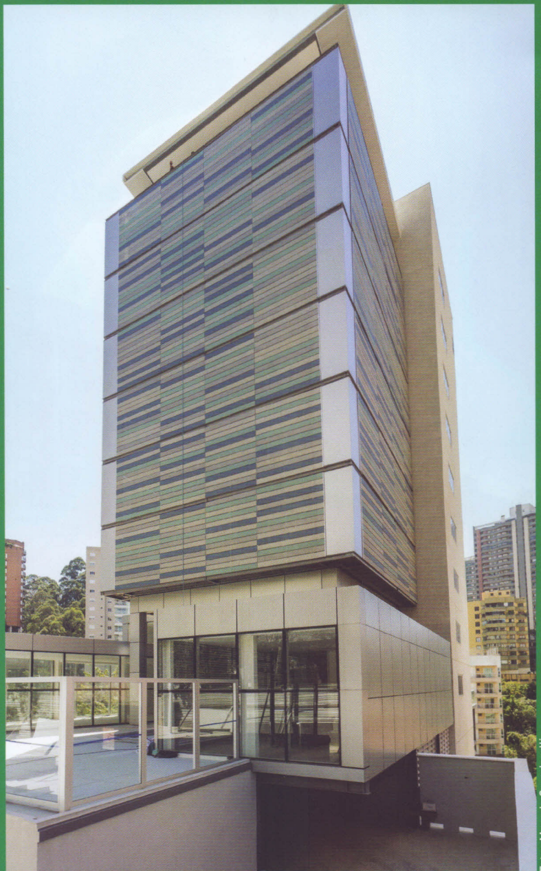
Prédio comercial, na zona sul de São Paulo, tem quatro pisos de garagens, térreo e sete andares, com cobertura. À direita, estrutura em perfis galvanizados formados a frio, por trás de esbeltos brises metálicos azuis, verdes e cinzas
