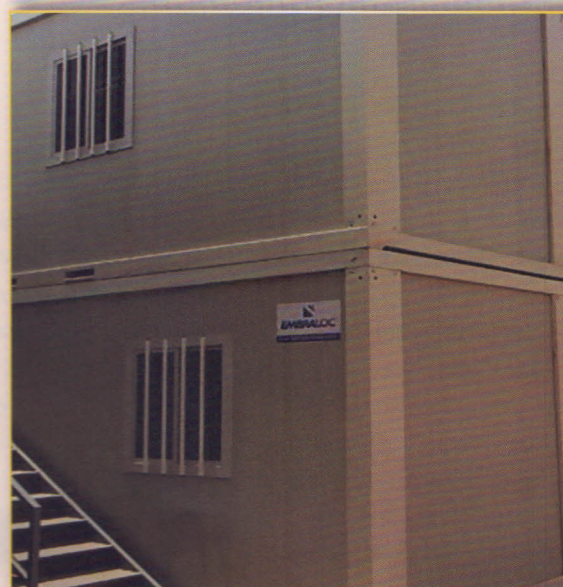
Em caso de empilhamento dos módulos é necessário que eles sejam fabricados com chapas grossas, conforme recomendação da Embraloc.
