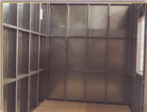
O fechamento lateral e a cobertura das unidades modulares são feitos com chapas fixadas por rebiteagem e/ou aparafusamento
