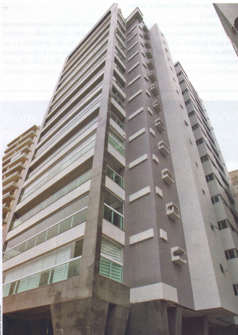
Valorização de bairros consolidados e busca por conforto proporcionado pelo aumento da área privativa motivam moradores a contratarem obras de acréscimo de varandas
