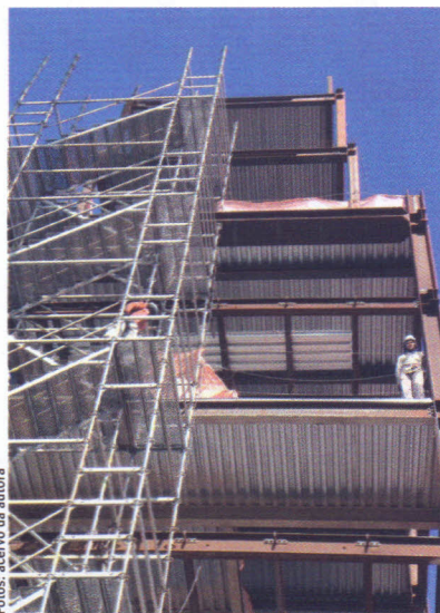
Figura 1 – Aplicação de steel deck em edifício de múltiplos andares
