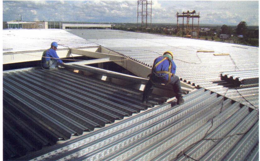
Figura 8 – Painéis posicionados e alinhados
