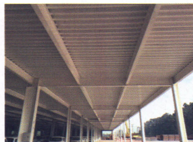
Figuras 2 e 3 – Face inferior das fôrmas pode ser pintada, garantindo maior durabilidade ao sistema
